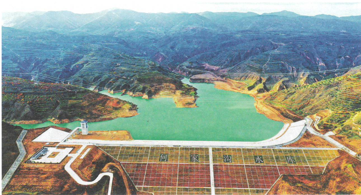
固原市黄河水调蓄工程新建的何家沟水库总库容达997万立方米。 闫院平/摄
